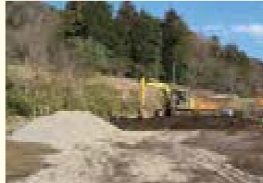
パークセンター一帯の盛土
