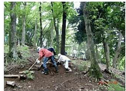
ボランティアによる階段補修
