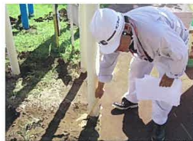
遊具定期点検
