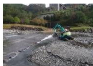
土砂撤去作業
