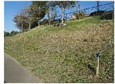
法面草刈りの様子
