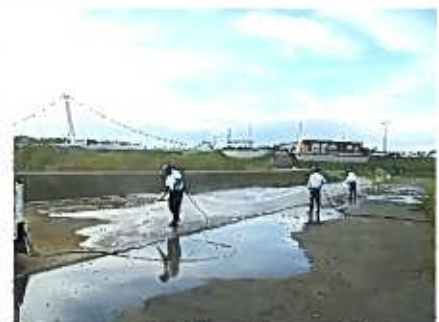
洪水発生時の作業の様子
