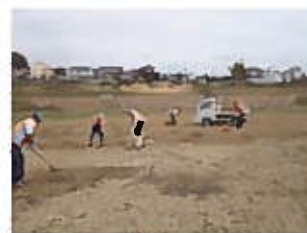
芝生に堆積した土砂の除去作業
