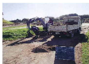
越流後の堆積土の除去作業
