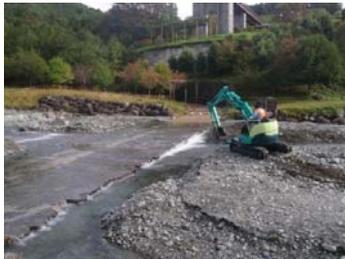
水無川の増水で冠水した橋上の堆積物を除去し安全を確保し通行止めを回避した
