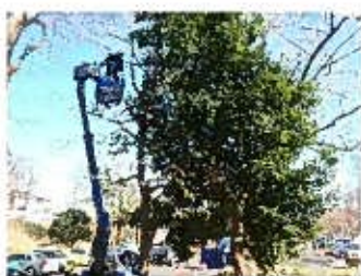
高所作業車による枝処理
