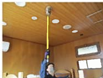
消防設備機器点検
