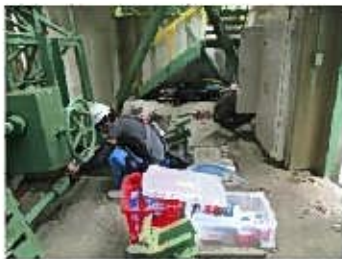
リードウォール保守点検
