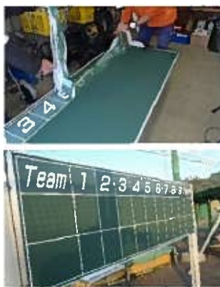
スコアボード補修作業
