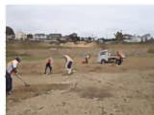
芝生に堆積した土砂の除去作業
