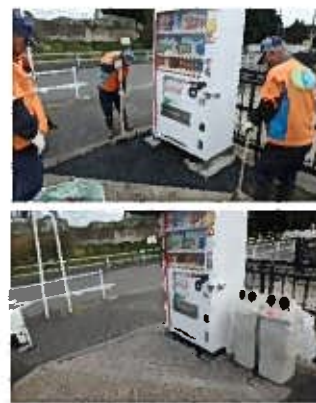
段差解消・廃材利用の舗装作業
