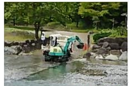
バックホーによる河川土砂の管理
