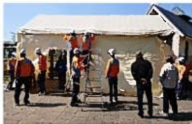
防災パーゴラの設営
