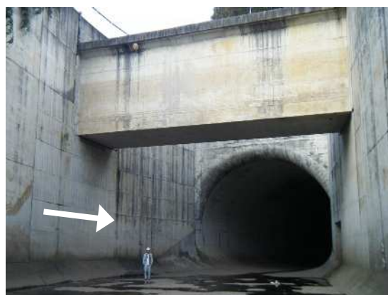
帷子川分水路
