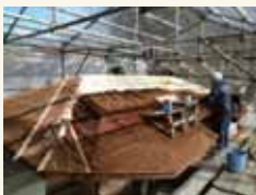
檜皮、板、垂木を解体し、状態の良い旧材を再利用しながら修復しました
