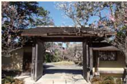
修復後の内門(屋根面積: 34㎡ 建築面積: 9.44㎡)
