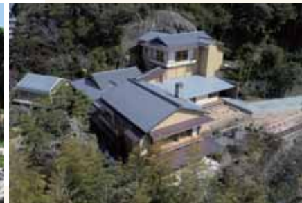
再建した旧吉田茂邸 (建築面積: 602.57㎡、延床面積: 743.38㎡)
