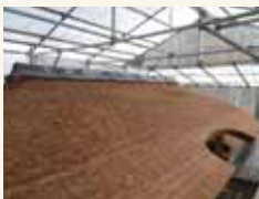
旧材を再利用して、棟瓦を葺き直しました
