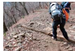
(水切り)流れてくる雨水を分散させるため登山道に斜めにかかる丸太や溝。雨水による登山道の浸食を防ぎます。写真は水路にたまった落ち葉を掻き出している所です。
