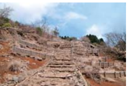
(階段と丸太の土留め)階段や木道で踏圧による裸地化を防ぎ、土留めにより土壌の流出を防ぎます。土壌が安定すればそこに飛んできた種で植物が育ち、更に安定します。
