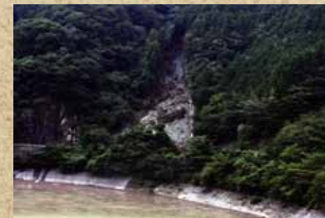
林道世附線 大崩落が起き、道路には土砂がうず高く流れ込んでいる
