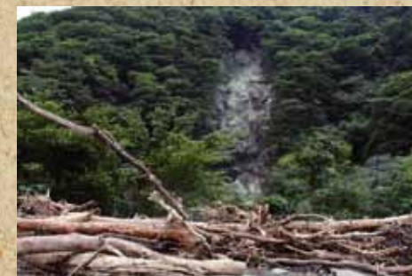
世附地区 道路には流れ込んだ水とともに流木が押し寄せ、対岸の山は削り取られている
