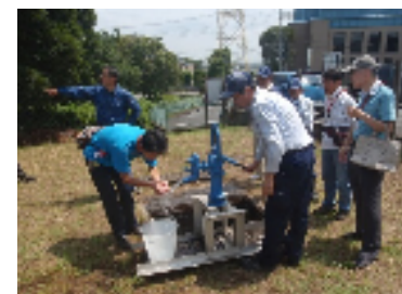
防災設備の作動確認
