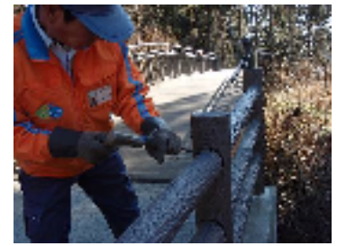
デッキ園路の点検
