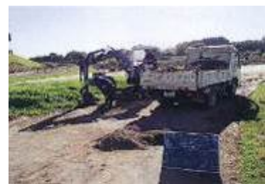
越流後の堆積土の除去作業
