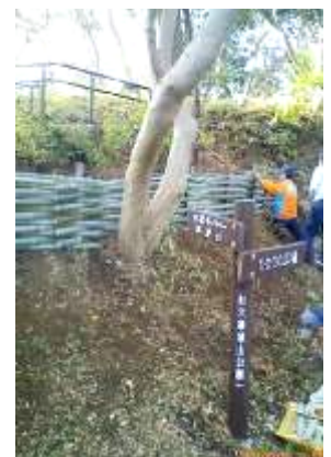
間伐竹を使ったシガラ設置
