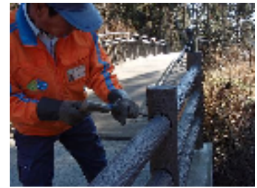
デッキ園路の点検
