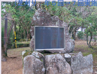
ベルツの碑は日常清掃時に石の 劣化の確認と碑面の汚れを点検
