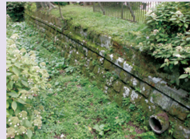
堀及び石垣は人通りが多いため 日常清掃を徹底します。
