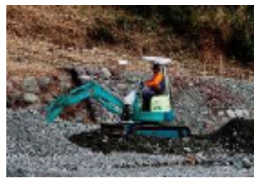
土砂撤去作業
