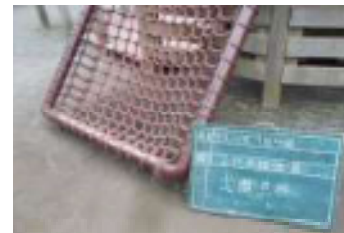
大型複合遊具点検②
