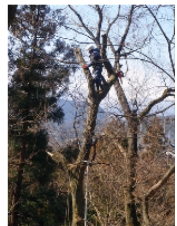
業者委託による 危険木伐採
