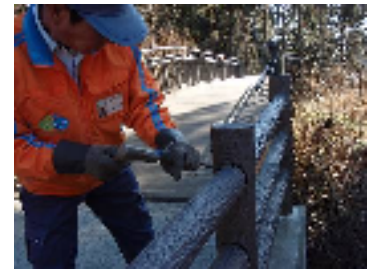
デッキ園路の点検
