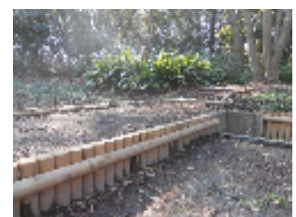
丹沢地域の間伐材を用いた丸太護岸
