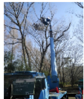
高所作業車での枝下ろし
