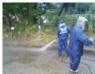
園路の高圧洗浄
