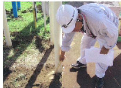
遊具定期点検
