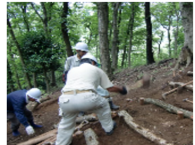
ボランティアによる階段補修
