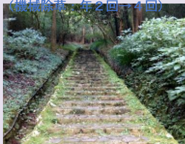
二百階段はコケの保存に配慮し つつ利用者の安全を確保します。
