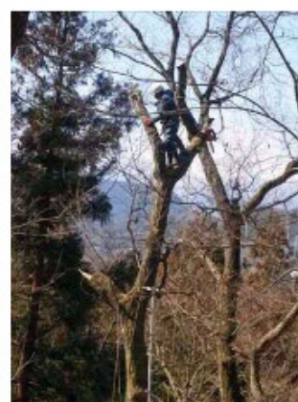
業者委託による 危険木伐採工
