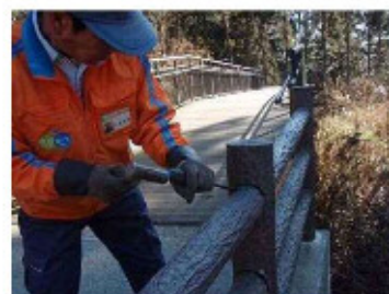
デッキ園路の点検
