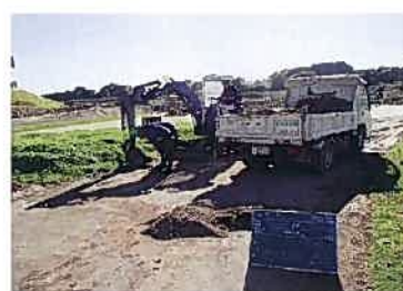
越流後の堆積土の除去作業
