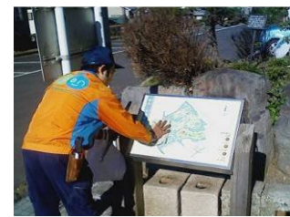
音声案内板の点検
