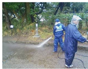
園路の高圧洗浄
