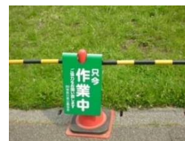
作業中看板の掲示
