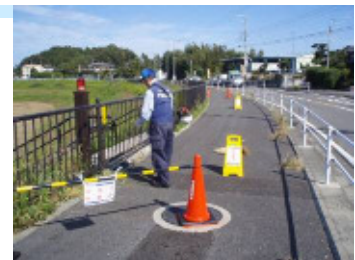
利用者安全を配慮した作業
