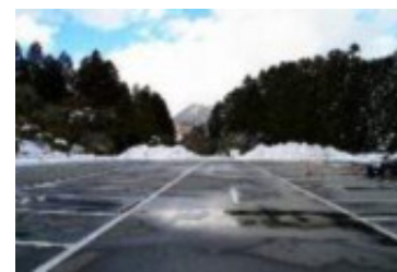
迅速に除雪作業をされ機能を確認した駐車場
