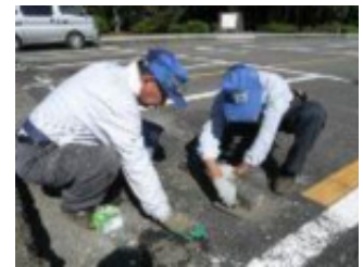
管理員による駐車場の車止め補修工
