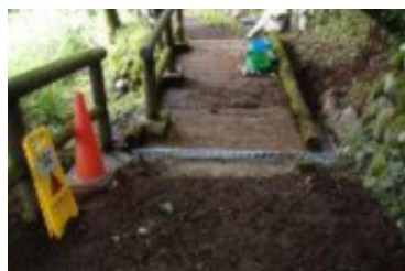
大雨により詰まった排水路の補修
