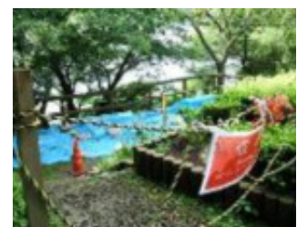
台風で崩れかけた法面を迅速に保護
