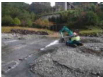
土砂堆積を除去
