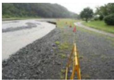
人止め柵の設置
