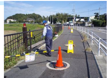
利用者安全を配慮した作業
