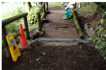
大雨により詰まった排水路の補修
