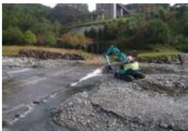
水無川の増水で冠水した橋上の土砂堆積を除去し安全を確保し即応性をもって通行止めを回避した
