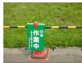
作業中看板の掲示
