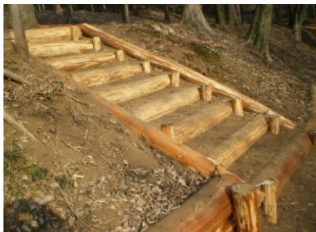
発生材の有効活用
