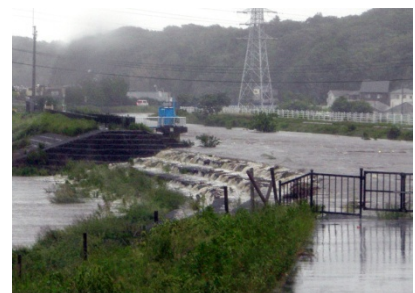
俣野ビオトープへの越流の様子 安全管理を念頭にしての状況確認
