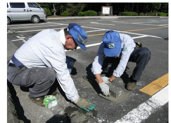
管理員による駐車場の車止め補修工
