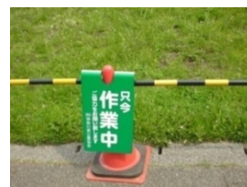
作業中看板の掲示
