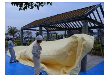
防災テントの設置訓練 (パーゴラに天幕を設営)
