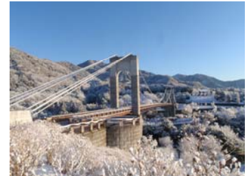
メインシンボル（風の吊り橋）
