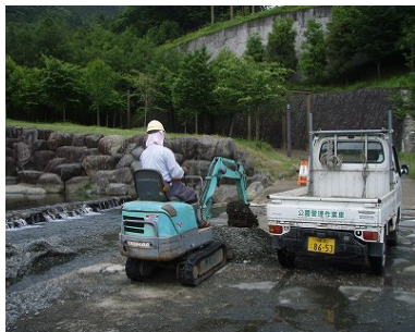
水無川の土石流で冠水した橋上の堆積物を除去し安全を確保し通行止めを回避した
