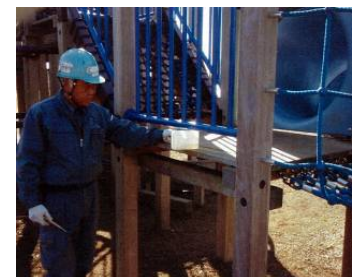
遊具は日常点検の他に専門業者が精密検査を行う
