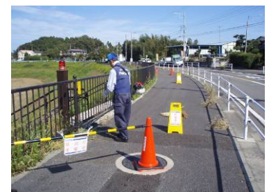
注意看板設置や、制限をし利用者安全を配慮した作業
