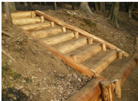
発生材の有効活用
