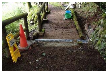
大雨により詰まった排水路の補修
