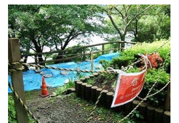
台風で崩れかけた法面を迅速に保護
