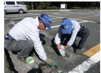
管理員による駐車場の止り止め補修工
