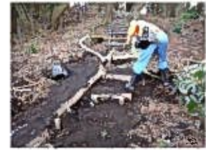
発生材を活用した小破修繕
