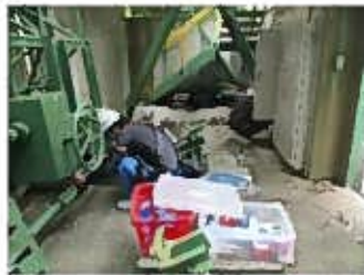
リードウォール保守点検
