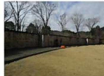
2mトラバース施設
