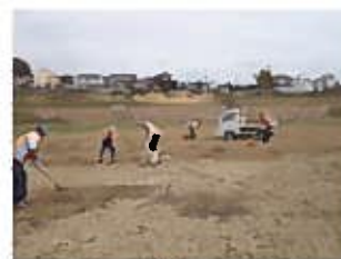
芝生に堆積した土砂の除去作業
