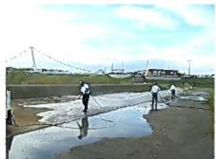
洪水発生時の作業の様子
