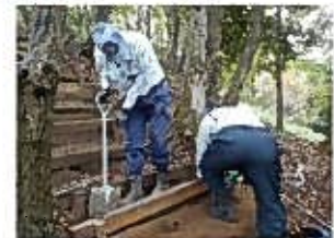
園内発生材を活用した小破修繕
