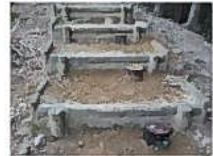
園路内の段差
