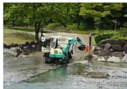
バックホーによる河川土砂の管理
