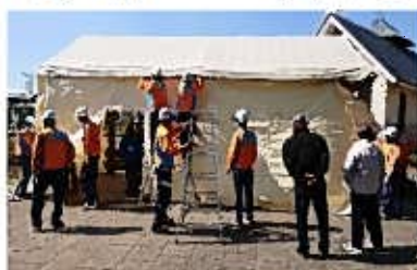
防災パーゴラの設営
