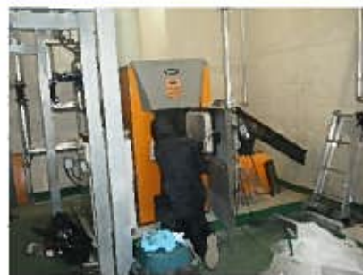
バイオマスボイラーの点検
